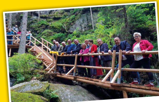
Errichtung neuer Aufstiegshilfen für den Lohnbachfall
